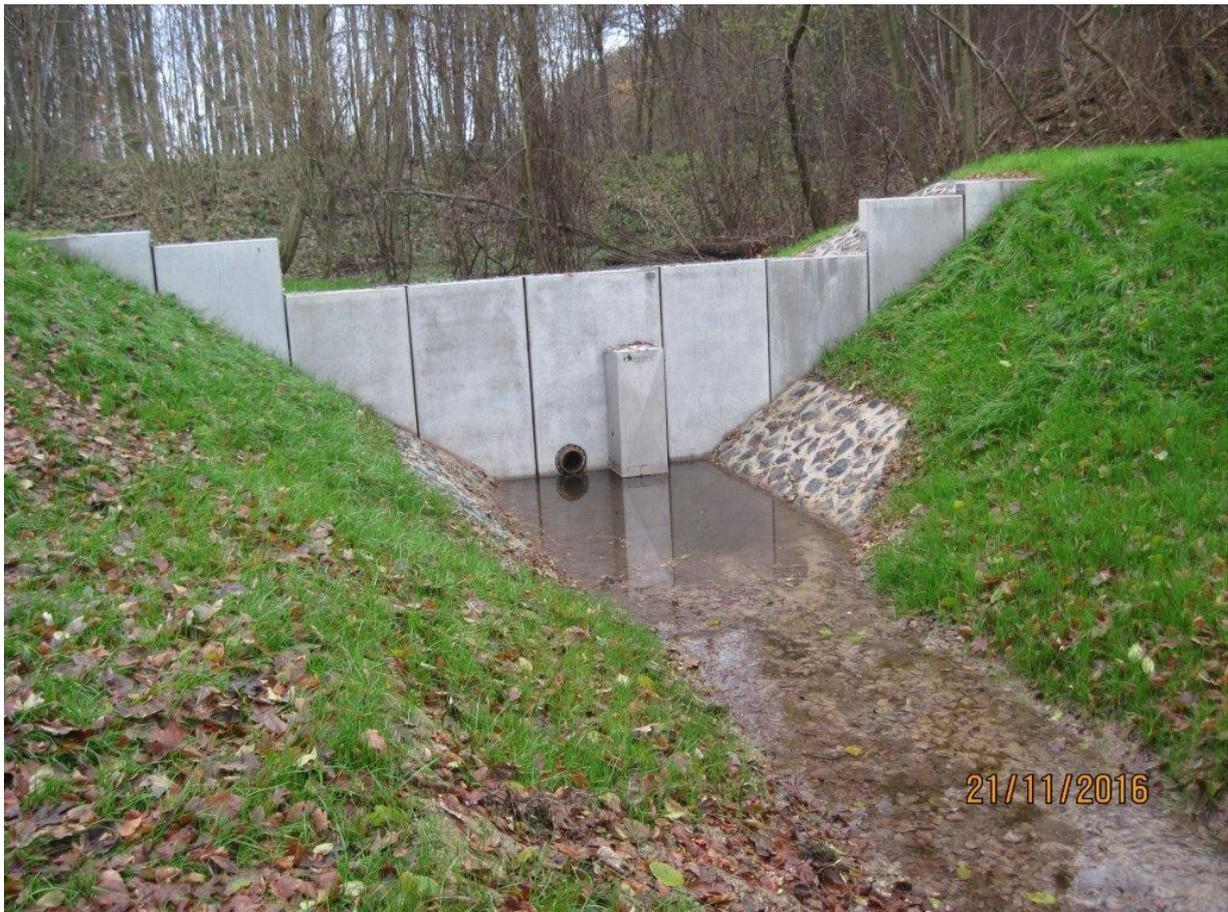
Zum Schutz des Seeburger Sees vor Verlandung wurde in der Friesenbeeke ein Dammbauwerk zu einem Sedimentationsbecken ausgebaut. Die Baumaßnahme wurde im September 2016 abgeschlossen.
